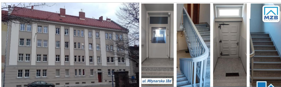
Fot. Wspólnota Mieszkaniowa przy ul. Młynarskiej nr 18D w Wałbrzychu – a) remont elewacji projekt ujęty w Gminnym Programie Rewitalizacji, realizacja ze środków UE b) remont klatki schodowej, realizacja ze środków własnych (źródło: MZB w Wałbrzychu)
