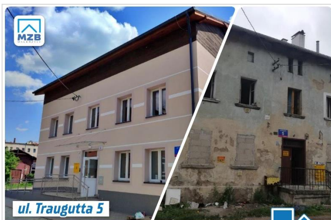
Fot. Budynek przy ul. Traugutta 5 w Wałbrzychu – kompleksowa modernizacja budynku. Zdjęcie przed, w trakcie i po inwestycji wykonanej w ramach rewitalizacji Śródmieścia (źródło: MZB w Wałbrzychu)
