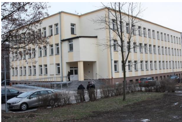
Fot. Budynek przy ul. Przywodnej 1 – przebudowa budynku oświatowego na cele mieszkaniowe, rok 2019 [źródło: FB Wałbrzych Moje Miasto]
