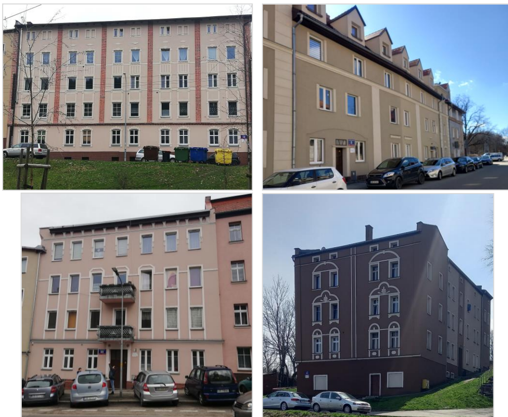
Fot. Przykłady realizacji wspólnot mieszkaniowych: Polna nr 14, Paderewskiego nr 5, Piłsudskiego nr 88, 1-go Maja 83 - dofinansowanie w ramach RPO WD 2014-2020 - Działanie 6.3 „Rewitalizacja zdegradowanych obszarów” - TYP B
