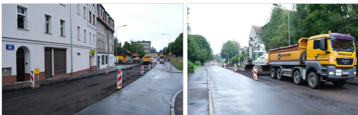
Fot. Ulica Niepodległości w trakcie przebudowy - rok 2021 [źródło: FB ZDKiUM]
