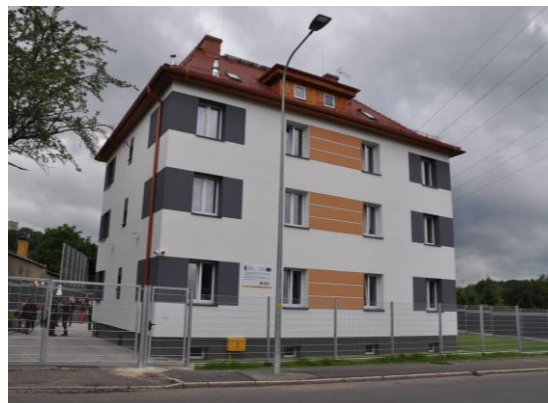
Fot. Budynek Domu Dziecka przy ul. Niepodległości 64 [źródło: FB Wałbrzych Moje Miasto]
